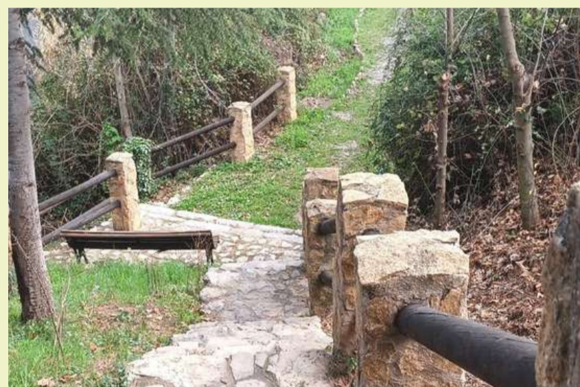
10. Paraje de la Grieta
