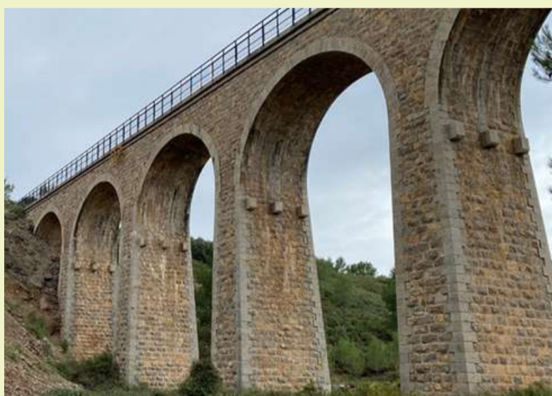
9. Viaductos de la Fuensanta
