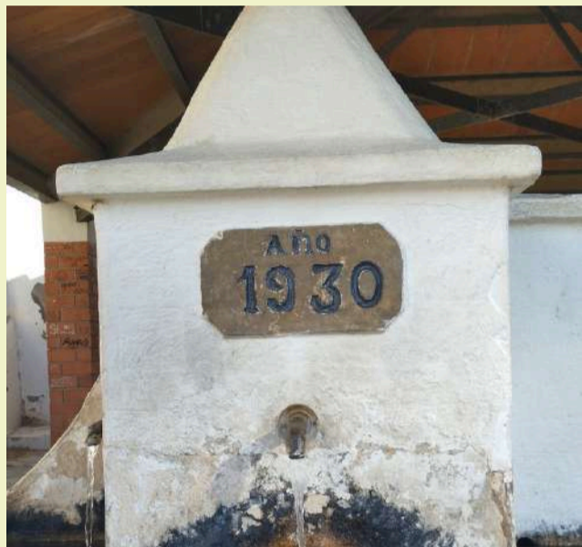
5. Lavadero calle Puente
